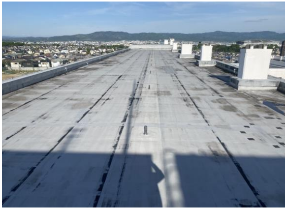
▲北棟校舎屋上（西側から撮影）
