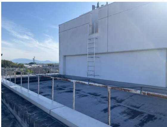
▲北館校舎屋上塔屋下（北東側から撮影）
