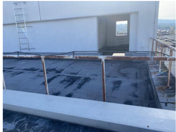
▲北棟校舎屋上塔屋下（東側から撮影）
