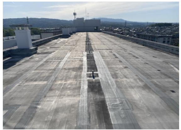
▲北棟校舎屋上（東側から撮影）
